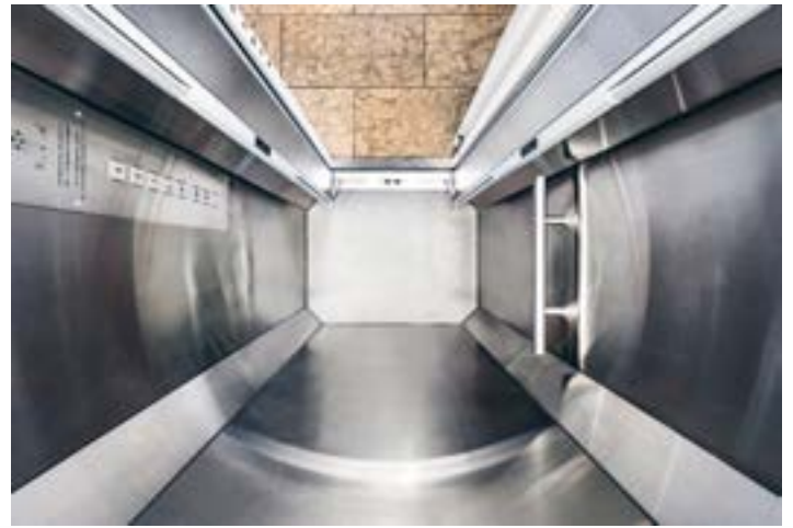
Grâce aux coins biseautés et à la porte pliante, la nouvelle cabine s'insère dans la gaine circulaire sans perte de place.
