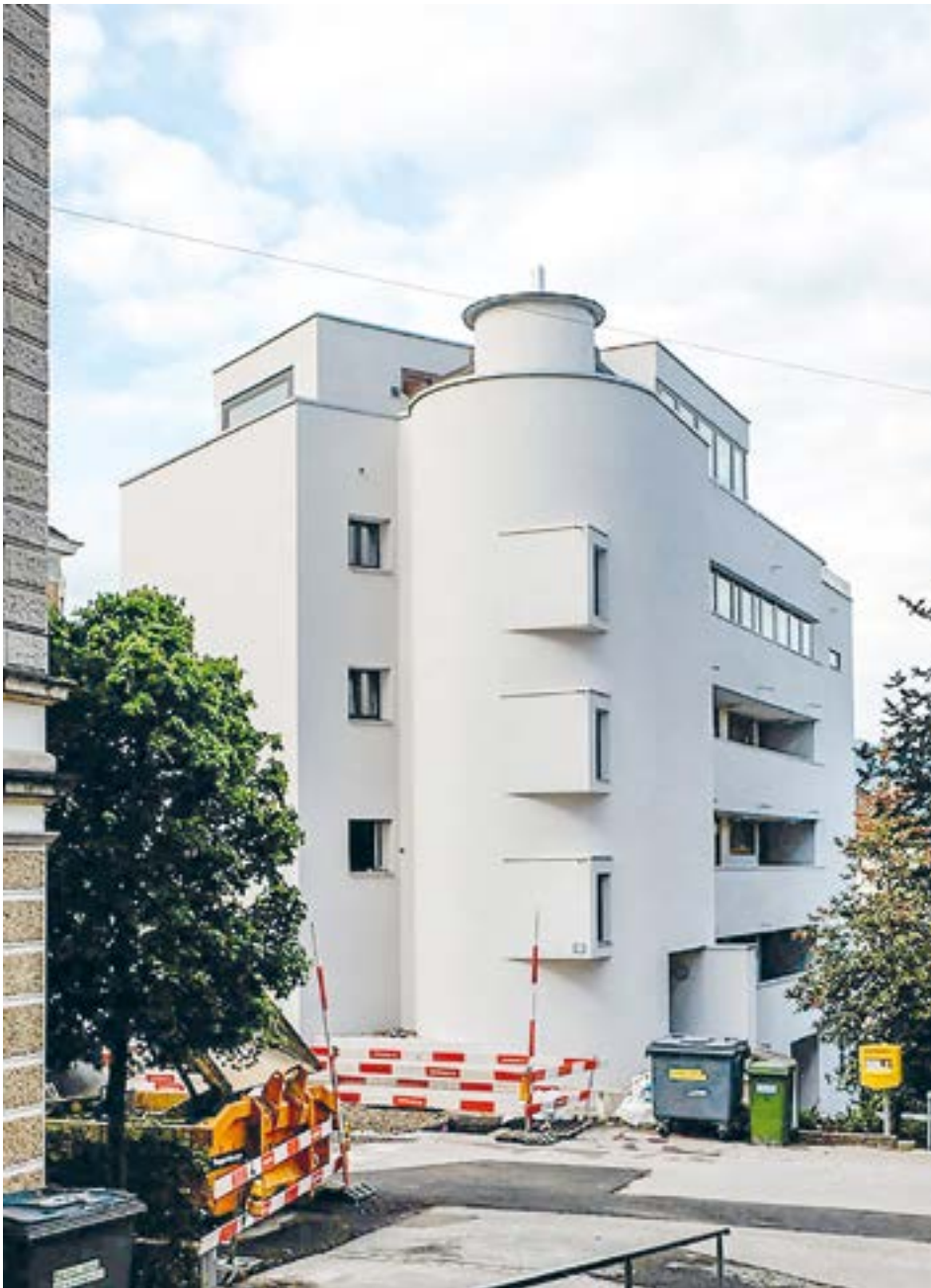
La maison d'habitation de la Clausiusstrasse à Zurich avec sa tour d'escalier circulaire.
