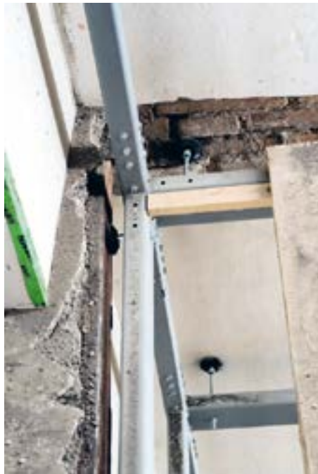
Ossature en acier et tampons d'espacement.
