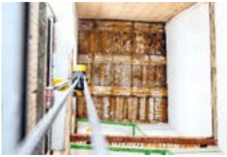
Vue sur les anciens plafonds à travers le puits entaillé.
