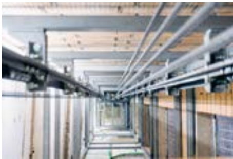
La structure métallique ajustée s'étend sur tous les étages.
