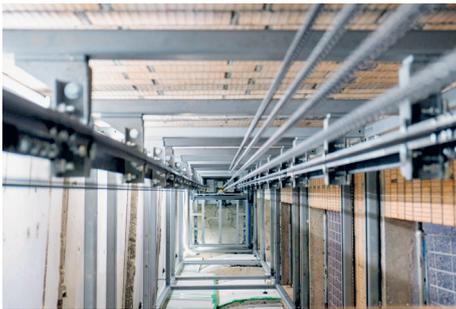
Das eingepasste Stahlgerüst geht über alle Stockwerke.
