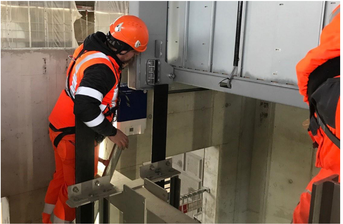
Montage de l'ascenseur dans l'aile sud de la gare principale de Zurich principale de Zurich
