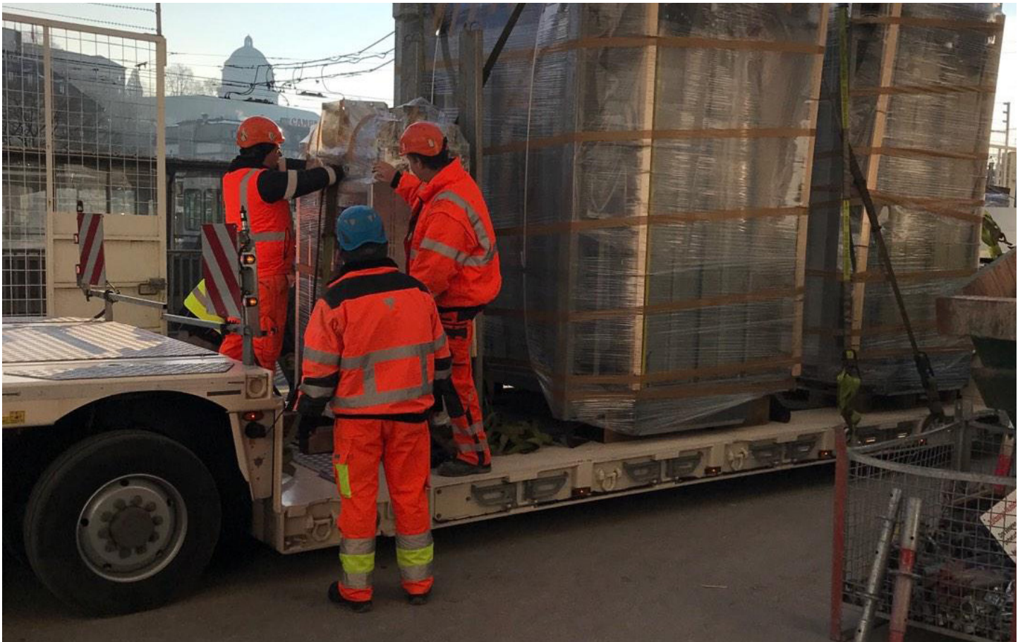
Liftmontage im Südtrakt des Hauptbahnhofs Zürich.
