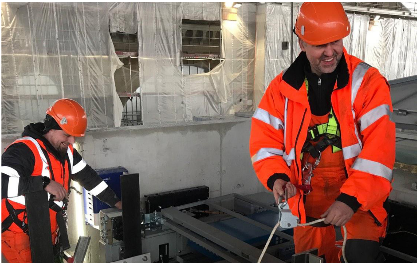
Liftmontage im Südtrakt des Hauptbahnhofs Zürich.
